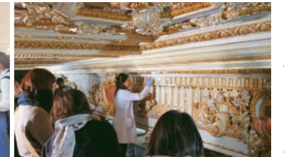
ドルマバフチェ宮殿の修復現場
