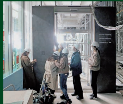
建築現場でのモックアップによるサインの検討
