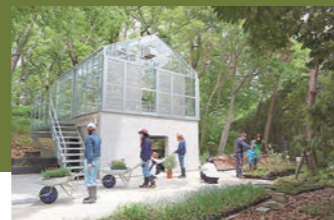
■ 実習用の植物を管理する「温室」
