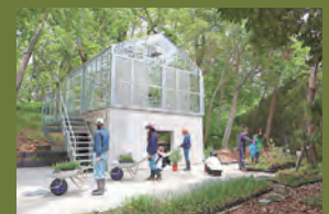
■ 実習用の植物を管理する温室
